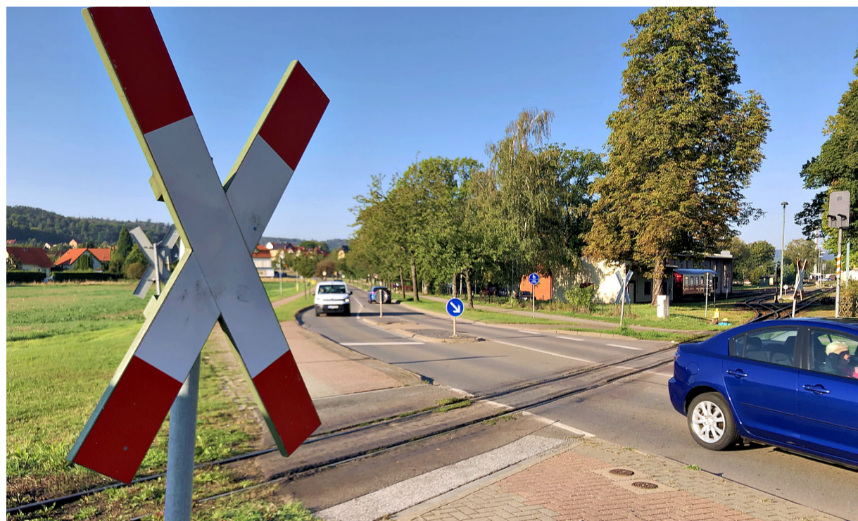
Durch Kraftfahrer viel frequentiert: der Bahnübergang in der Otto-Franke-Straße in Gernrode. Er ist einer von insgesamt 86 auf der Strecke der Selketalbahn, von denen bislang 26 über technische Sicherungsanlagen verfügen. FOTO: KORN
